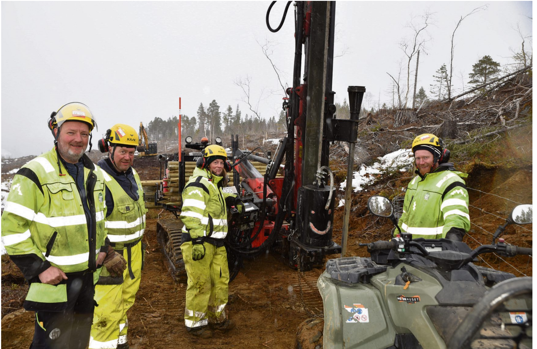
Hallgeir Haugan (t.v.), Anders Rønning, Ida Nordheim Aune og Tore Haugan i den lokale bedriften HT Gjerde Trøndelag Sør setter nå opp et 1,5 mil langt gjerde langs den nye E6 traseen i Rennebu. Gravemaskina i bakgrunnen med Olav Svahaug bak spakene rydder veg for gjerdinga. Foto: Jan Inge Flå
